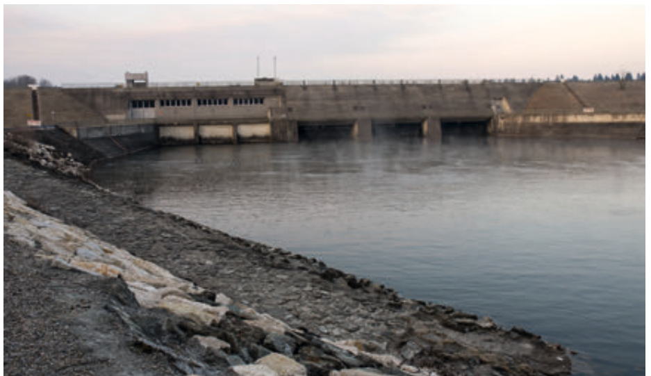
Ein gewaltiges Bauwerk: Die Staustufe 19 bei Klosterlechfeld
